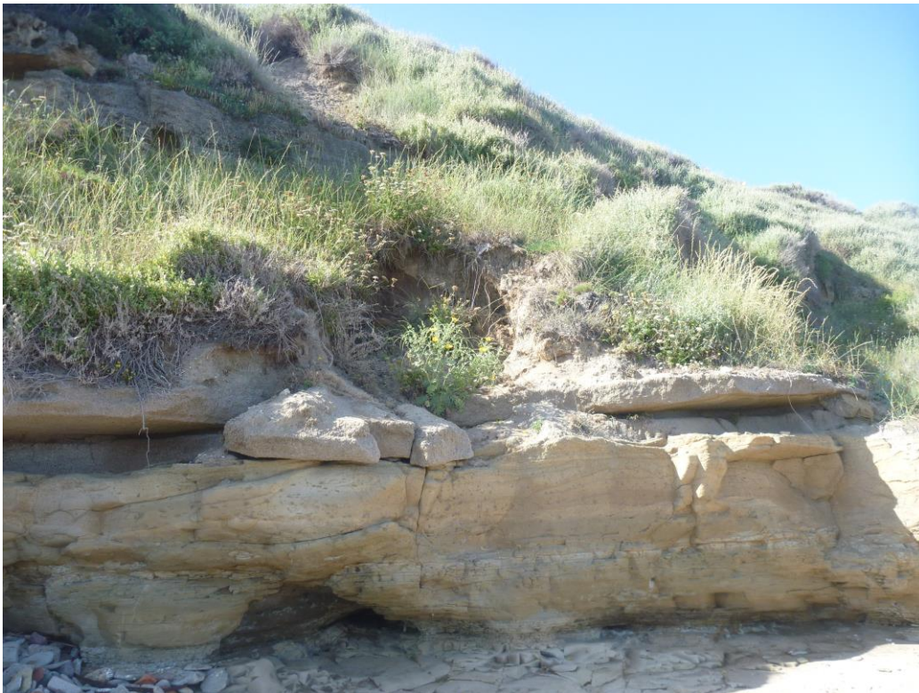
Foto 2: Smottamento in corrispondenza del crollo di un livello arenaceo sottescavato.
